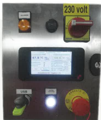
Pannello elettrico con Plc e chiavetta Usb per registrare le lavorazioni. Electrical panel with PLC and USB pen drive for recording processing.
